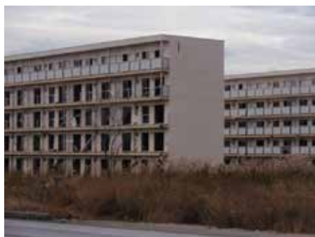
図2 陸前高田市沿岸部で被災した共同住宅 (2011.10.31撮影)
