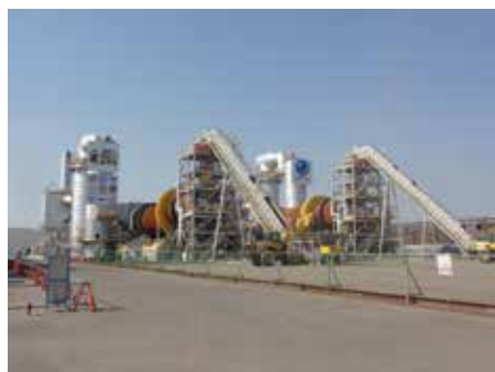
図15 仮設焼却炉(ロータリーキルン)
