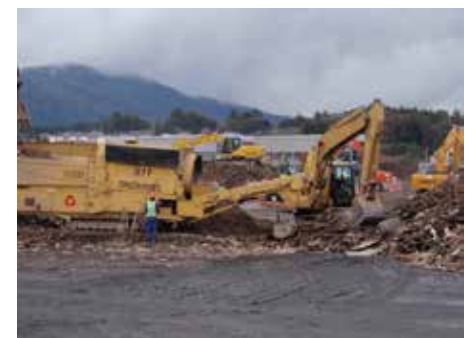
図6 篩選別による可燃物と土砂の分別 (2011.10.31撮影)
