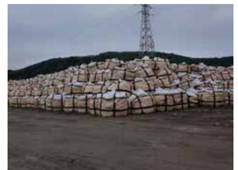
図4 フレコン詰め混合廃棄物の集積状況 (石巻市南境地区にて、2012.5.23撮影)
