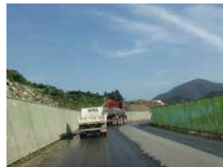
図16 女川町の一次仮置場
