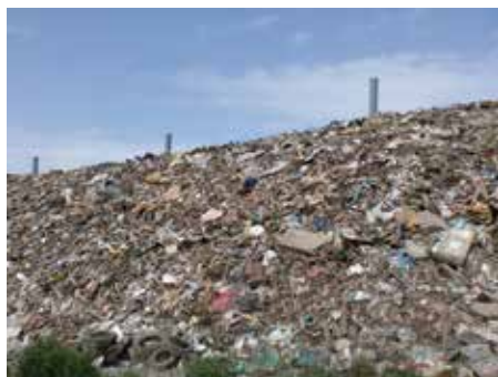
図6 一次仮置場におけるガス抜き対策（石巻市雲雀野地区 2012.5.23撮影）
